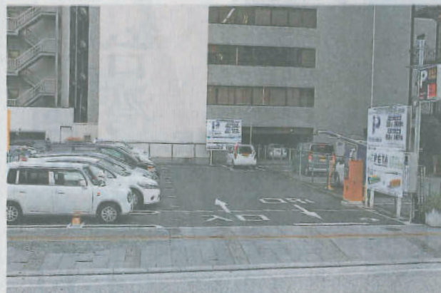
遠隔管理システムを導入した駐車場 岡山県岡山市
